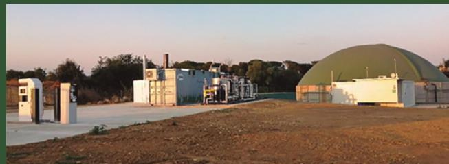
Para producir el biometano, el biogás se somete a un tratamiento conocido como «upgrading» para la inyección en la red gasista. En dicho proceso se elimina principalmente  $\text{CO}_2$ , componente mayoritario, pero también se elimina humedad, sulfuro de hidrógeno, amoníaco, compuestos orgánicos volátiles,  $\text{O}_2$  y  $\text{N}_2$ , entre otros. De este modo, la proporción de metano aumenta hasta que el gas puede considerarse biometano o metano de origen renovable.
